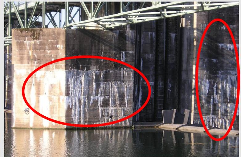
Die Betonierfugen weisen teilweise ein deutliches Bild von Ausspülung auf
